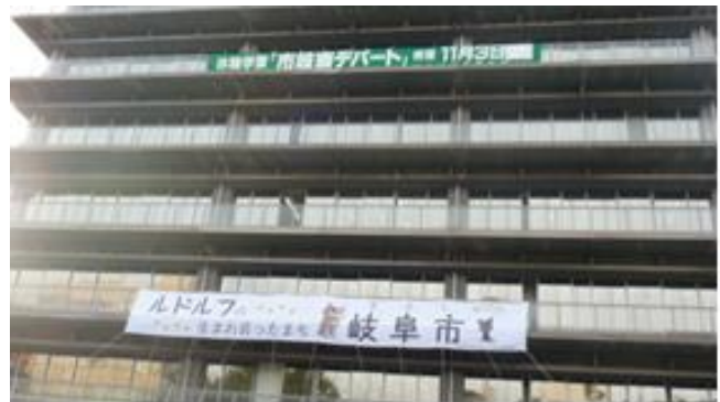
市役所本庁舎に横断幕が設置されました
